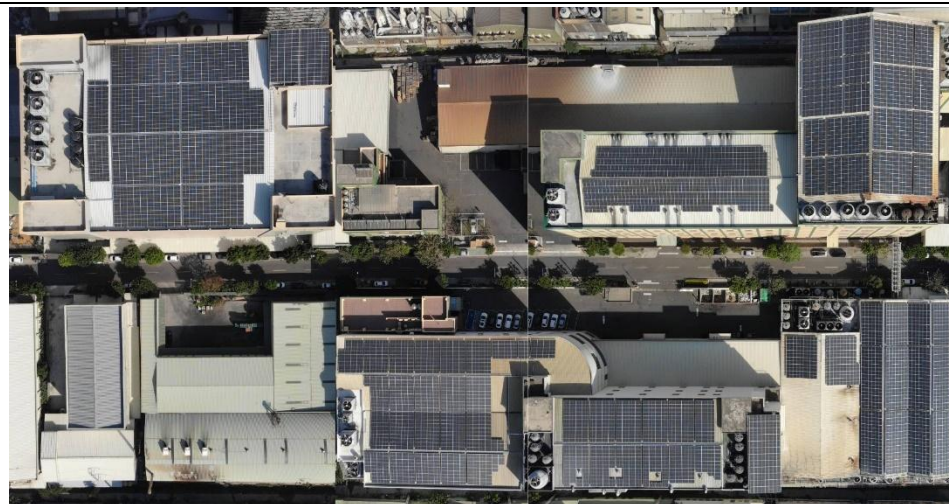
彰化廠安裝太陽能光電板
